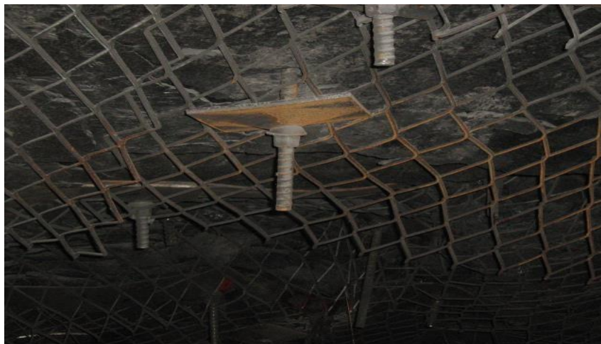
1.6-сурет – Анкерлік бекітпенің орналасу схемасы
